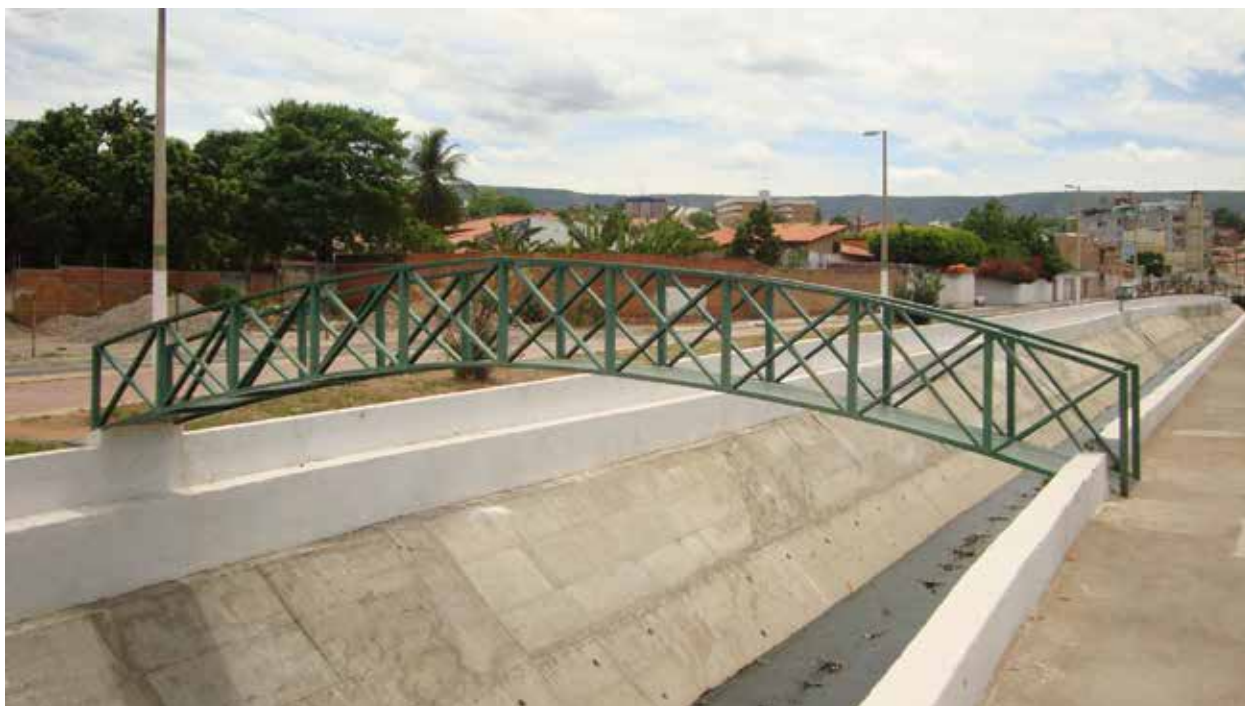
Figura 3. Passarela metálica reconstruída sobre o canal do rio Granjeiro, em 2014, na cidade de Crato/CE. Fonte: SEDEC/MI.
